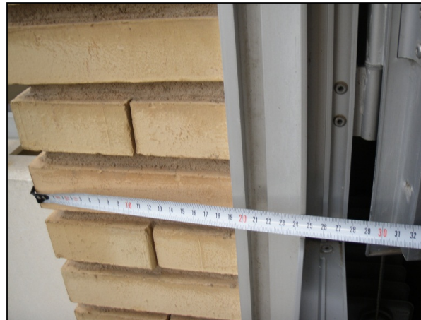
Espesor del muro
